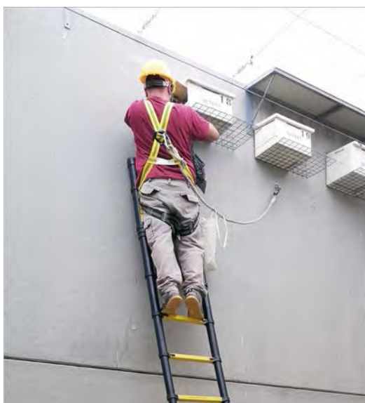
Foto 7 – Revisión, limpieza y cierre de nidos, por un técnico de DEMA. Fuente: DEMA.
